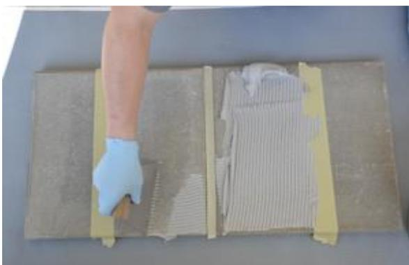
Нанесите эпоксидный клей на поверхность. Он должен выступать за края ленты на 2-3 см.
