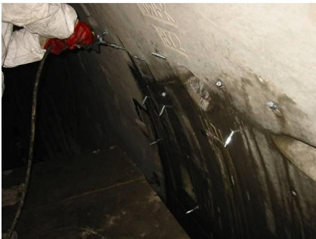
TamPur 150 это однокомпонентный гидрофильтрный полиуретан в комбинации с полизэфирными полиолов. Реагирует лишь при смешивании с водой и по окончанию реакции образует эластичный герметизирующий материал.
